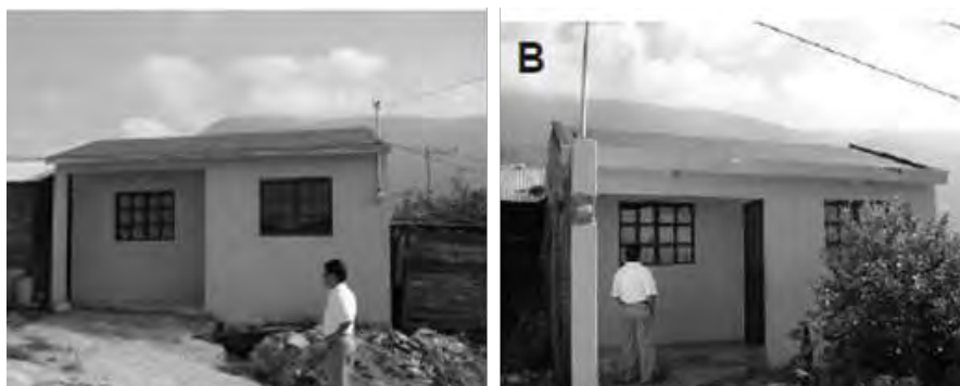
Figura 1.36. Construcciones del programa 10x10 Chiapas. En la foto A, vivienda cubierta con Cerámica Armada, propuesta por Universidad de la República, Uruguay. En la foto B, vivienda cubierta con Placa Losa propuesta por la Facultad de Arquitectura de la Universidad Autónoma de Chiapas, México.
