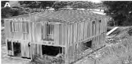
Figura 1.5. Vivienda en construcción con tecnología Sipromat en Venezuela.
