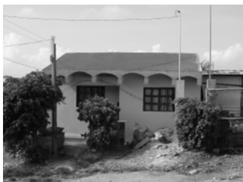
Figura 1.38. Construcciones del programa 10x10 Chiapas. En la foto, vivienda cubierta con bóveda Ferrocemento, propuesta por la Universidad Autónoma de Yucatán, México.
