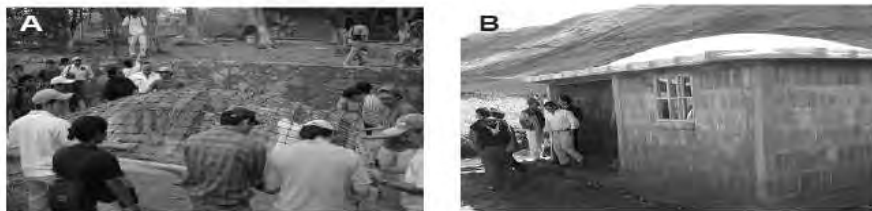
Figura 1. 3. La foto A, sistemas de techo Cúpula mortero armada en el taller 10x10 Chiapas. Ing., Luis Leyva. En la foto B, los sistemas de techo Cúpula mortero armada en 10x10 Ecuador.
