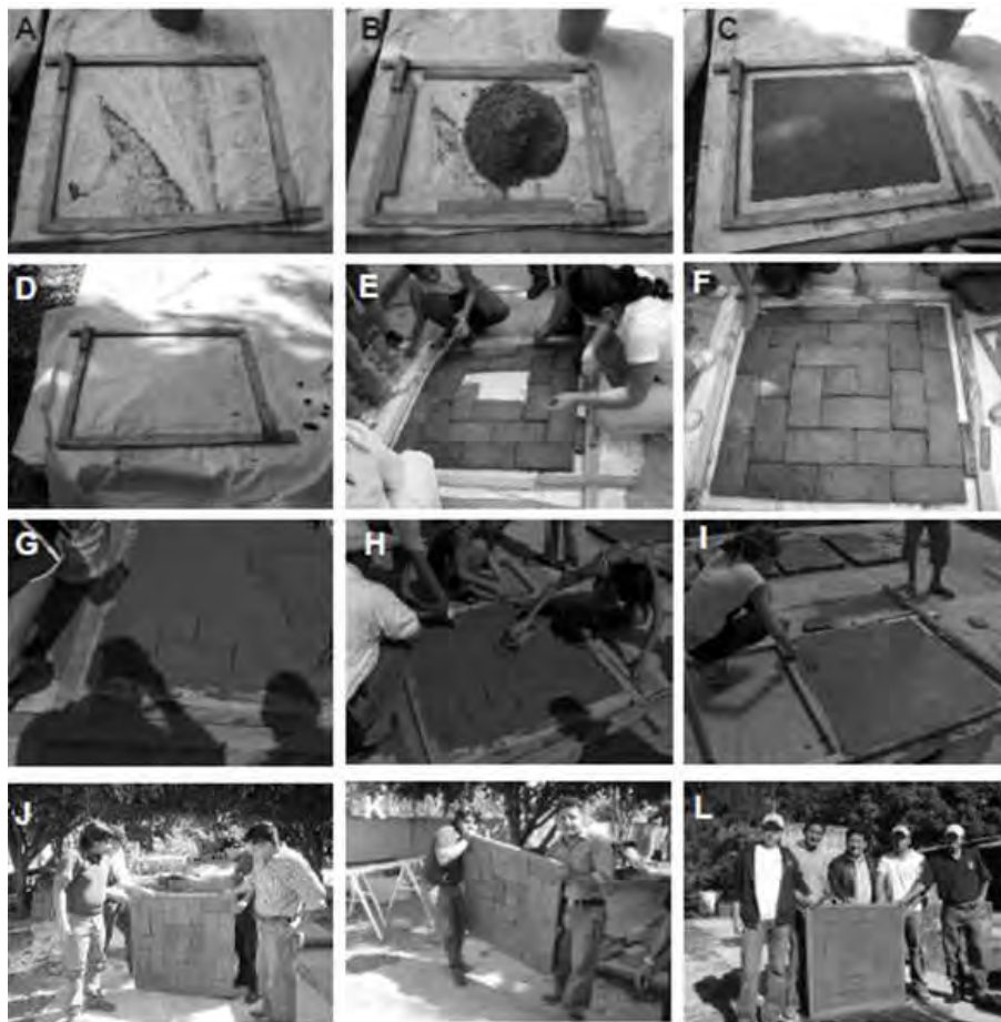
Figura 2.17 - Proceso de prefabricación del componente de techo Domotej. Las fotos A - G muestran el proceso seguido para la prefabricación de componentes.
