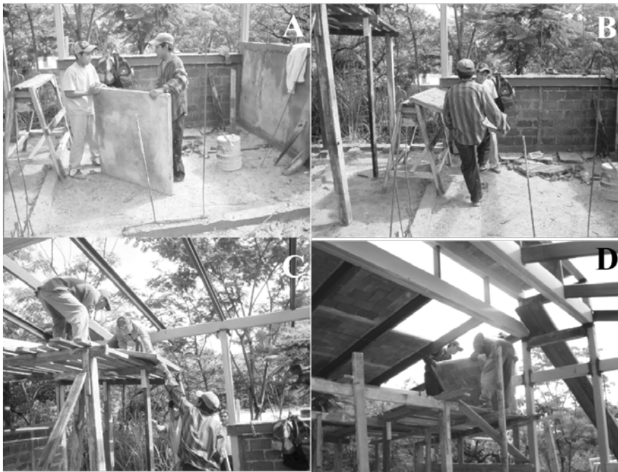
Figura 3.21. Colocación de componentes techo Domotej sin la necesidad de equipos especiales
