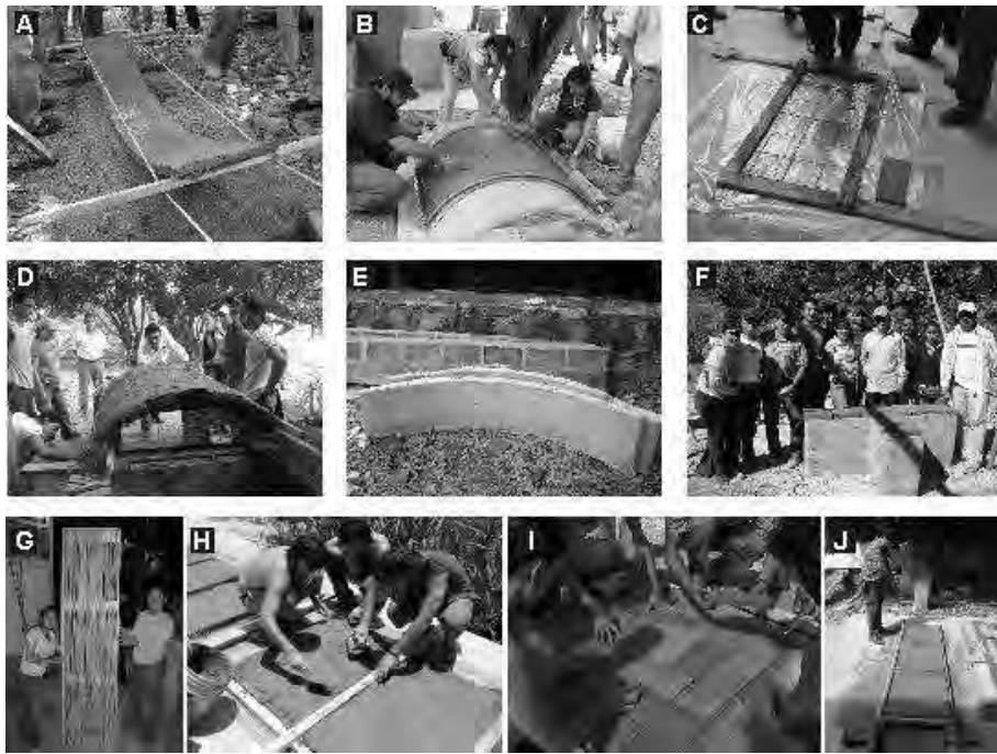
Fig. 3.43. Tecnologías que se imparten en los talleres de transferencia de tecnología. Fotos: A, Dovela de ferrocemento, B- Bóveda de ferrocemento, C-placa losa y techo térmico, D, Bóveda con cimbra deslizable. E-Cerámica armada. F, Muro Tapial. G-Muro Quincha prefabricada. H, Muro térmico. I-Do-motej. J, Domozed.
